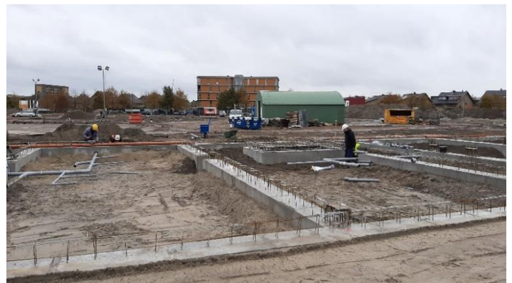
Fundering en riolering
